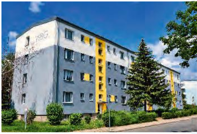
neue Fassade in der Kükenthalstr. 1 – 5
